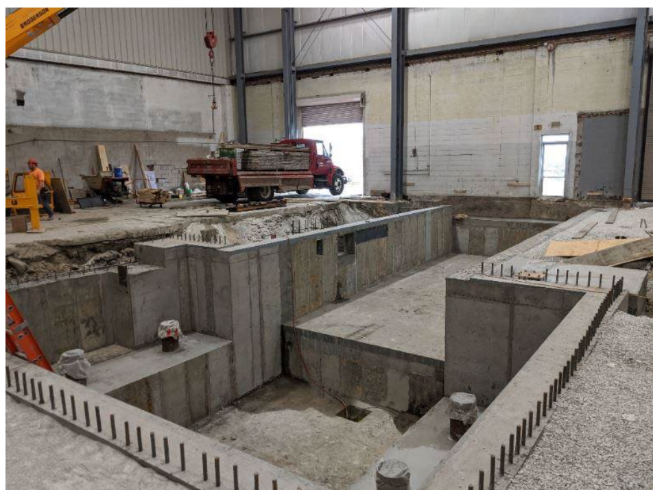
Рис. 5.2 – Схема встановлення центрифуги на фундаменті
