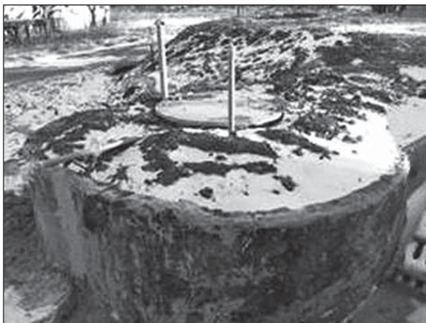
Рис. 2. Зовнішній вигляд водозабірної свердловини
